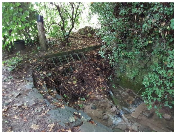
Einlauf der Bacheindolung am 5.7.18
