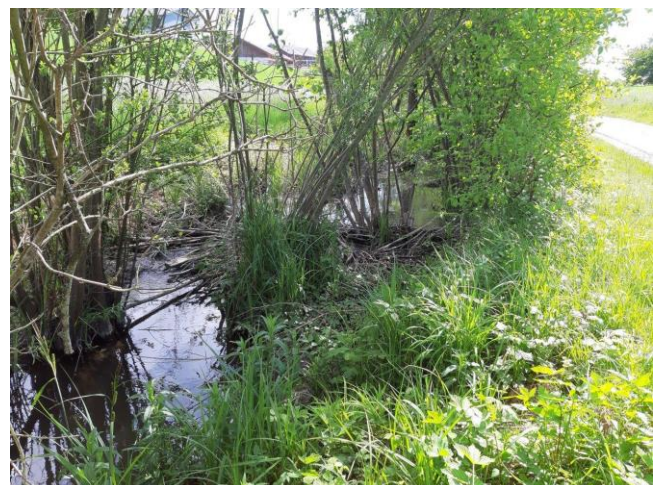
Auflandung entlang Schulweg 2021
